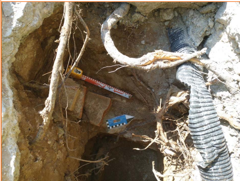
Foto 6. Vista des de l'est d'un mur UE 34 de l'edifici del número 5-7 del carrer dels Segadors.
